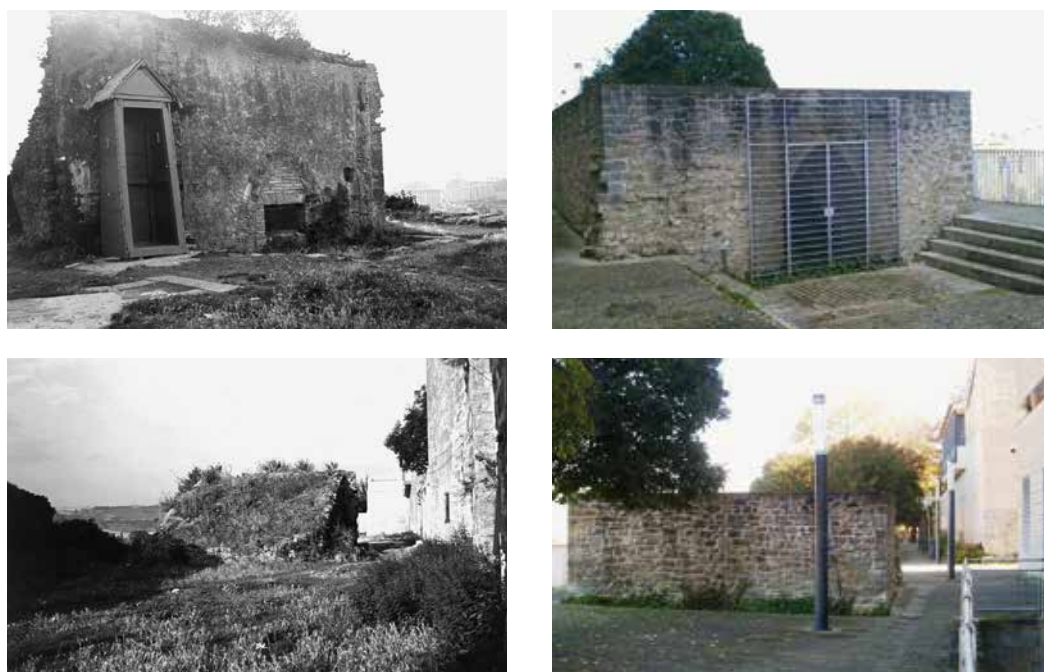
Figura 3. Vistas del frente y trasera de la nevera aneja al Palacio Real antes y después de su reforma. Izda: AMP, Colección Arazuri, autor desconocido, 1969; derecha: Sara González, 2020.
