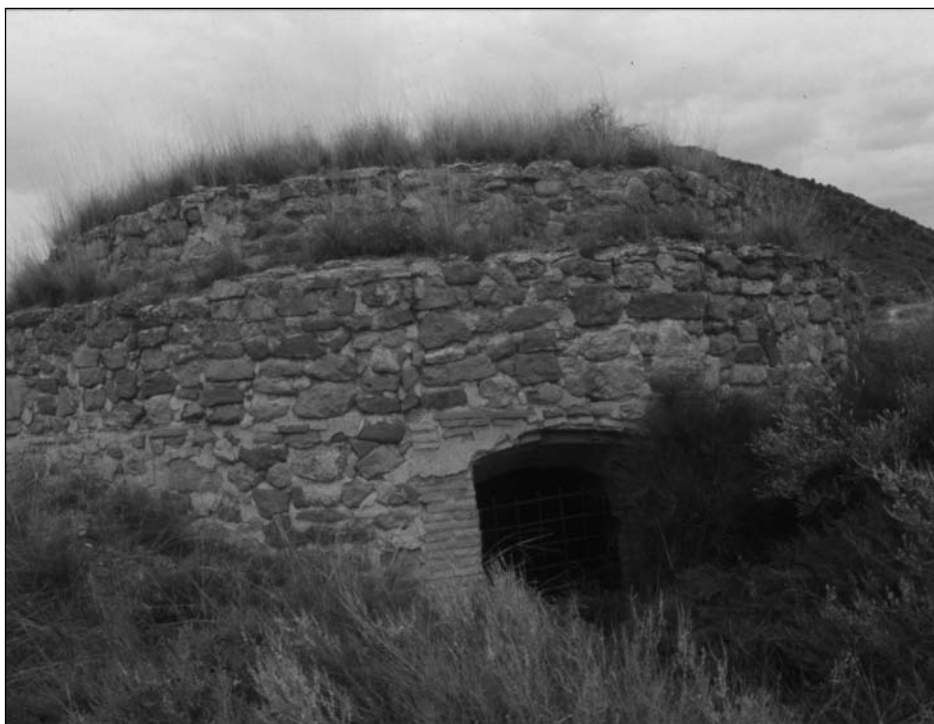
Nevero de Fitero que daba servicio al balneario (fotografía del autor)
