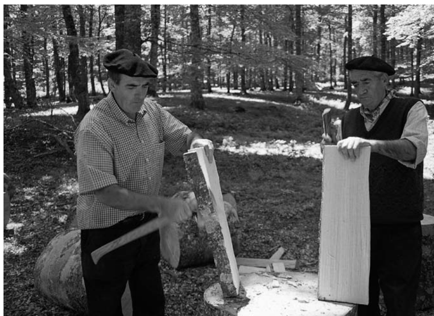
Rajando y preparando las tablillas para el tejado (mayo 2006).
