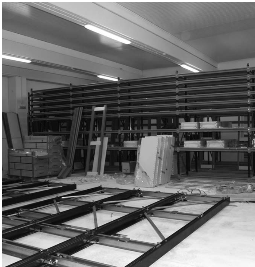
Montaje de estanterías en la nave de Merkatondoa (mayo 2007).
