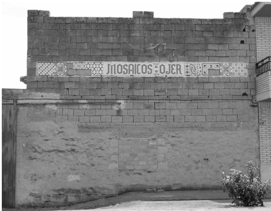
Fachada de la antigua fábrica de Mosaicos Ojer, en Santacara, con el letrero elaborado en mosaico hidráulico (Fotografía del autor)
