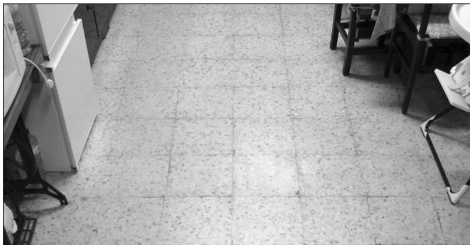
Solado de terrazo en un edificio construido a mediados de los 60 (Fotografía del autor)
