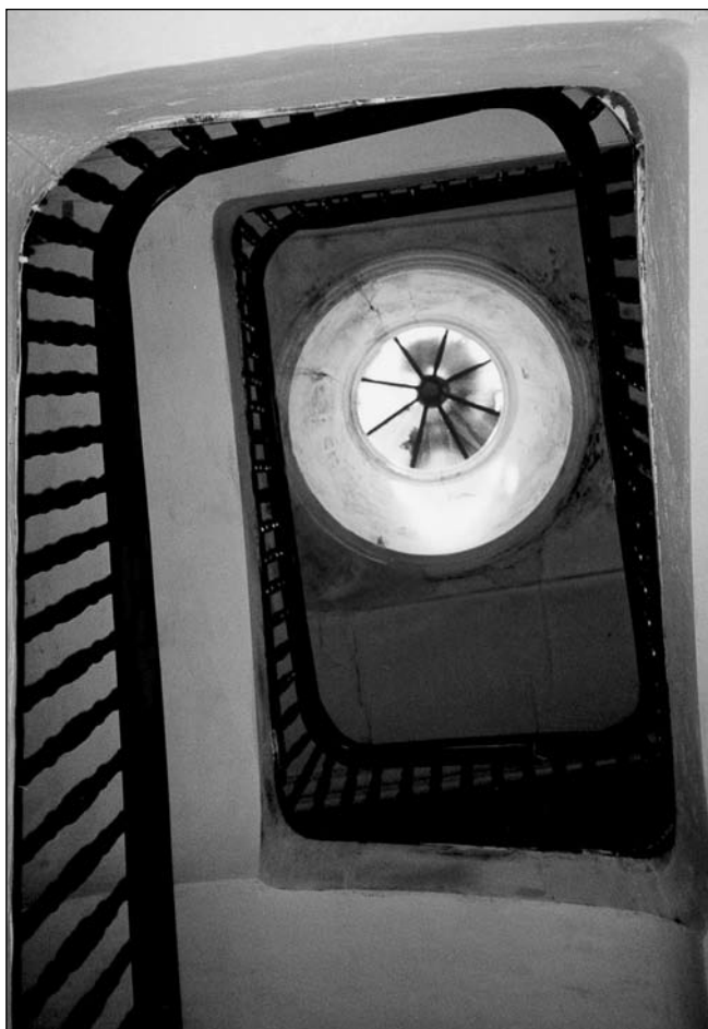
Escalera y claraboya
