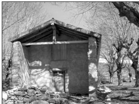
A la izquierda detalle conjunto de la fachada de la borda y la chabola del pastor, a la derecha la fachada, en donde se muestran perfectamente los avances de los muros laterales o "frailes"
