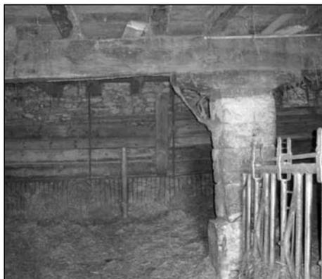
Los pilares centrales de las bordas, siempre tienen la parte inferior en piedra, y el resto son vigas de madera, o son columnas hechas en piedra, para evitar que la madera esté en contacto directo con la humedad y estiércol en el suelo, y evitar así la rápida pudrición de la misma
