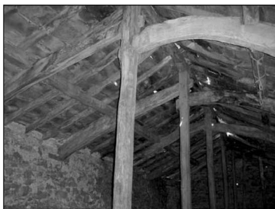
Estructura de la cubierta, interesante por la sistemática elección de vigas curvadas
