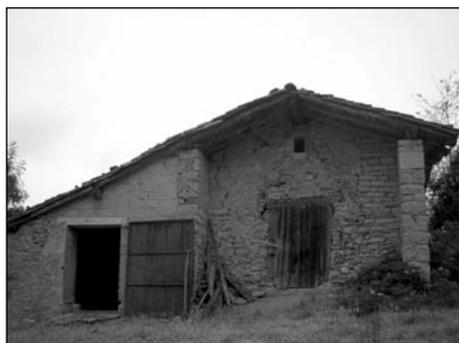
Bordas de tipología subatlántica. Se sitúan en el piso montano por encima de los 700 m. Son de planta rectangular, alargadas. Tienen cubierta de teja árabe, con poca pendiente
