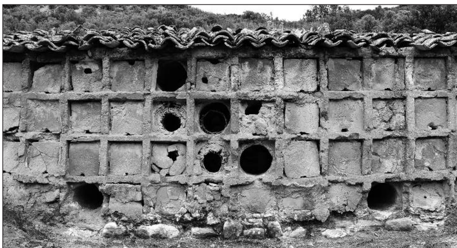
Ventanas, huecos, casillas, con tapas y sin tapas.
