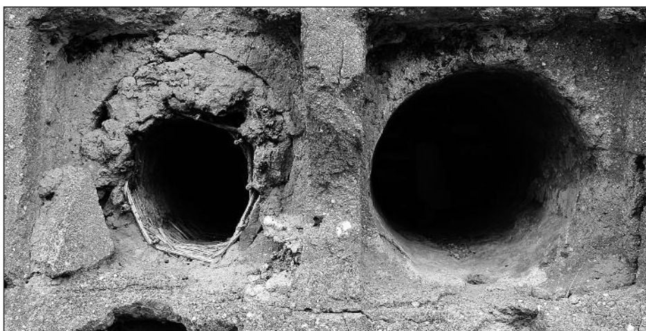
Vaso de cañas fijado en una ventana y ventana sin vaso.
