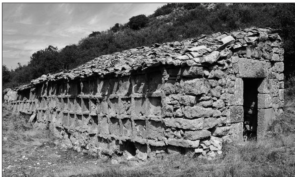
Pared o fachada principal.
