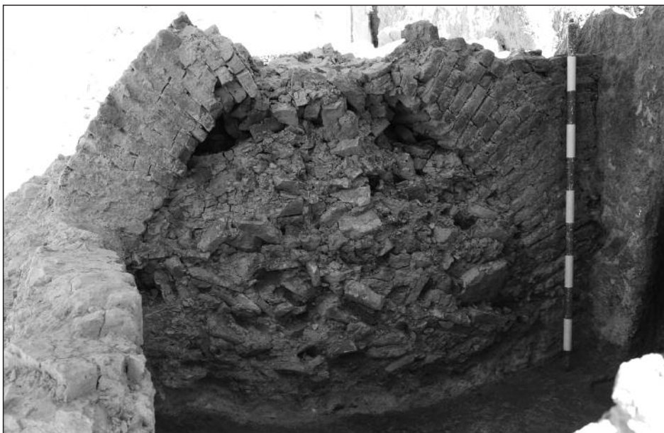
Colmatación de derrumbe de la cámara de combustión.
