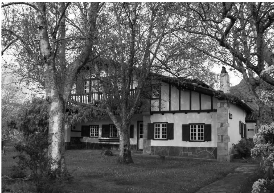
Figura 3. La casa Bidartia en su estado actual.
