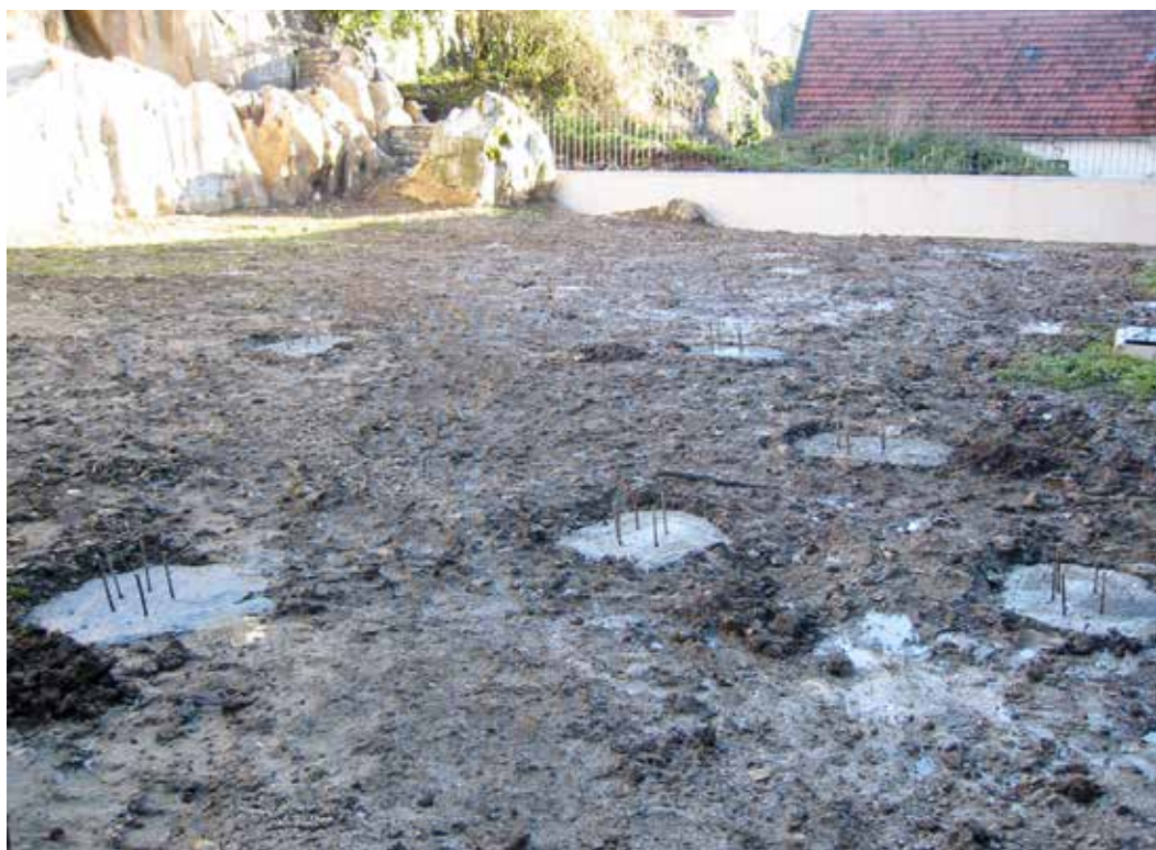
Figura 13. Bases para asegurar las estelas al terreno.
