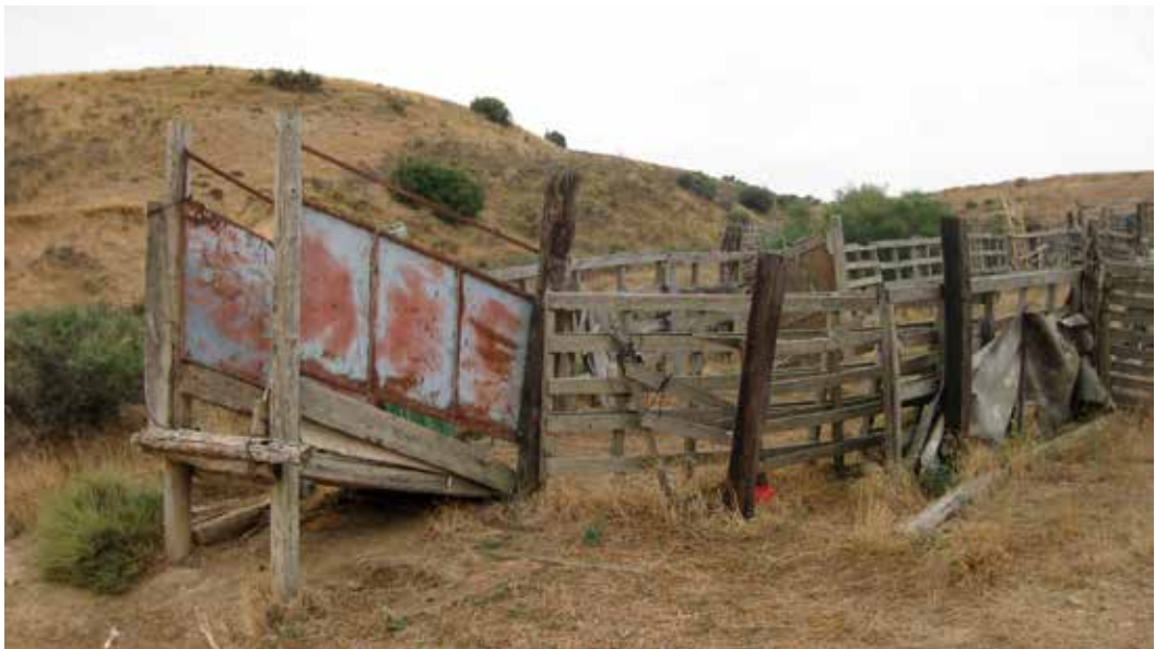
Figura 12. Zona de embarque en la Barrera de Los Forcajos (Javier Nuin).
