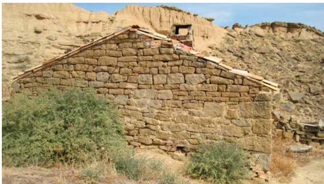
Figura 35. Caseta de pastor del Corral de Cornialto con cubierta a dos aguas (Javier Nuin).
