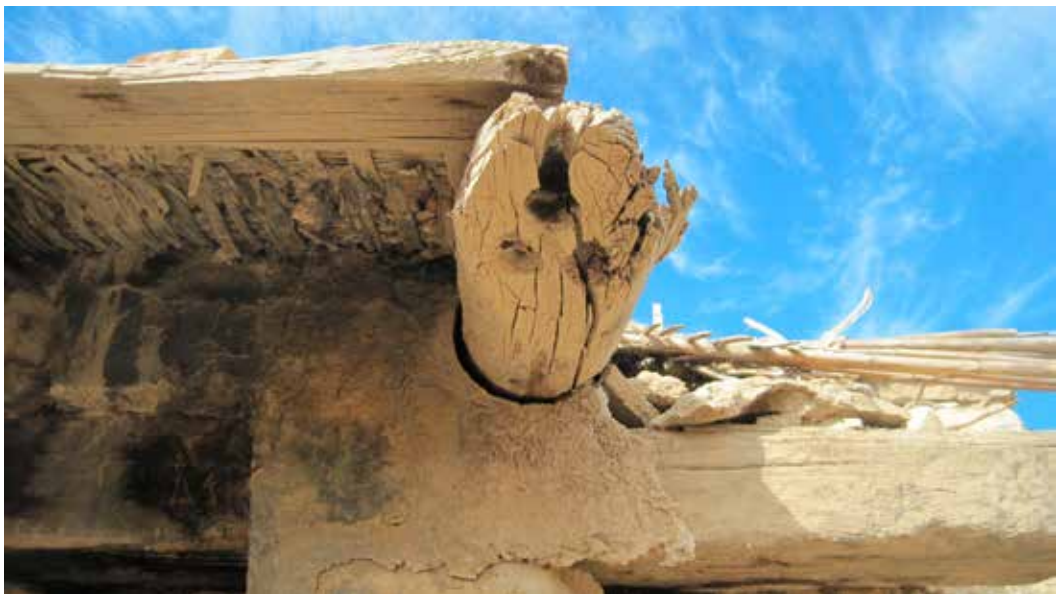
Figura 34. Detalle de viga traída en almadía (Javier Nuin).
