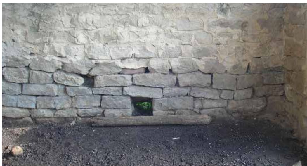
Figura 40. Orificio para drenar ubicado en el serenao del Corral del Salinero (Javier Nuin).
