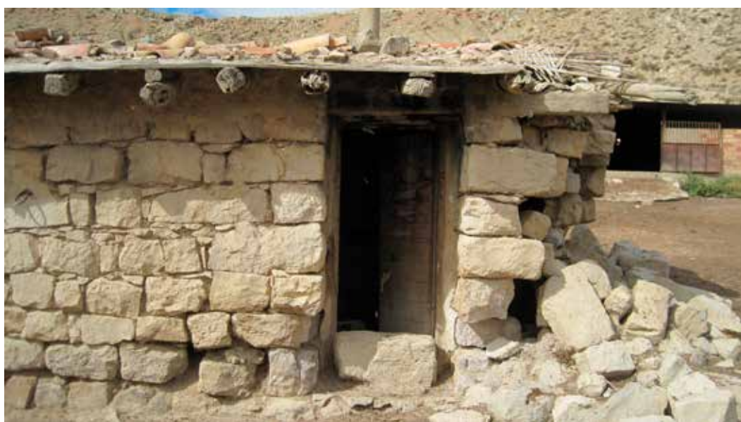
Figura 32. Aparejo irregular de sillería en el Corral de Pérez (Javier Nuin).
