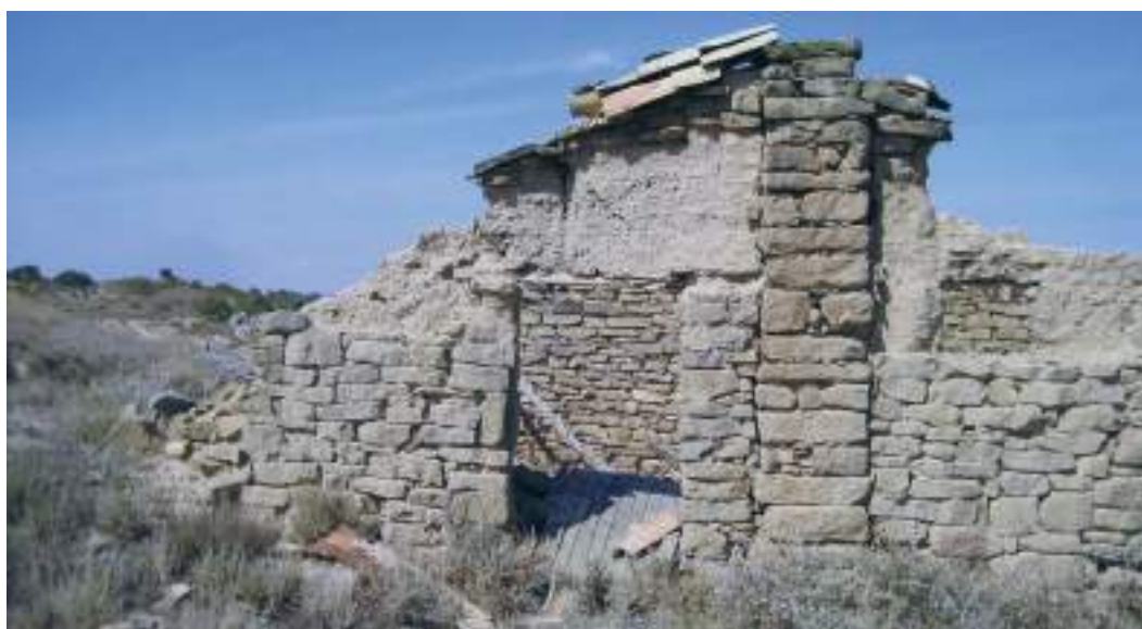
Figura 10. Estructura con adobas en la Cabaña de Ventura (Txaro Mateo).
