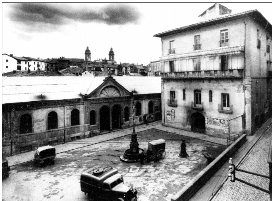
Fig. 24. Casa Consistorial y Plaza de Santo Domingo, hacia la que se prolongará el edificio municipal. Año 1950. AMP (Foto Julio Cía)
