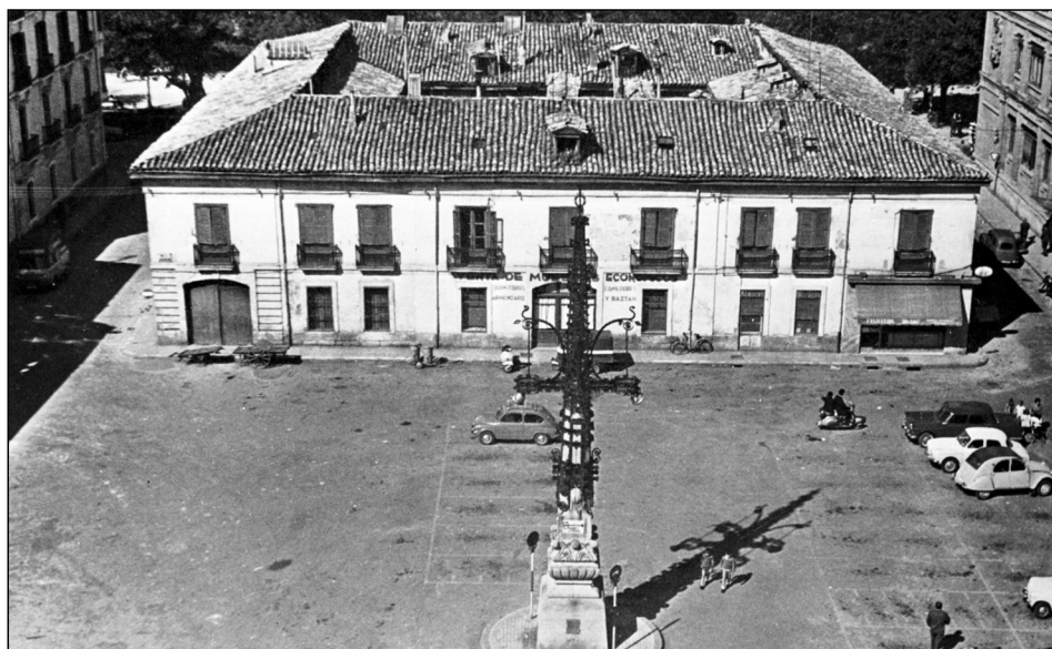
Fig. 5. Plaza del Vínculo —entonces de la Argentina— y Casa de los Baños, convertida en almacenes. Año 1965. AMP (Foto Javier Galle)
