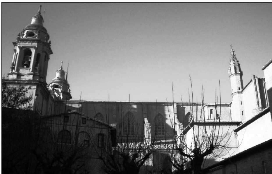
Figura 16. Vista lateral de la catedral de Pamplona
