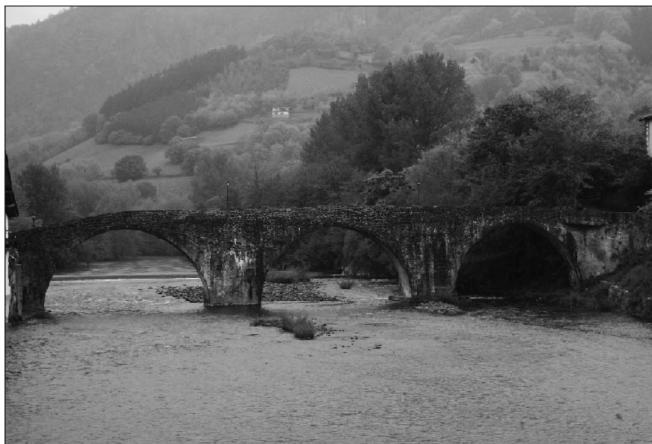
Vista actual del puente de piedra de Sunbilla
