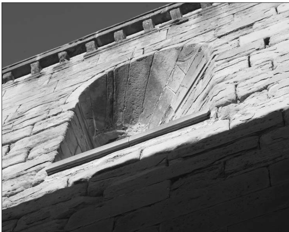
Fig. 19. Lerín. Parroquia de Nuestra Señora de la Asunción. Detalle de la ventana en esviaje de la capilla colateral izquierda
