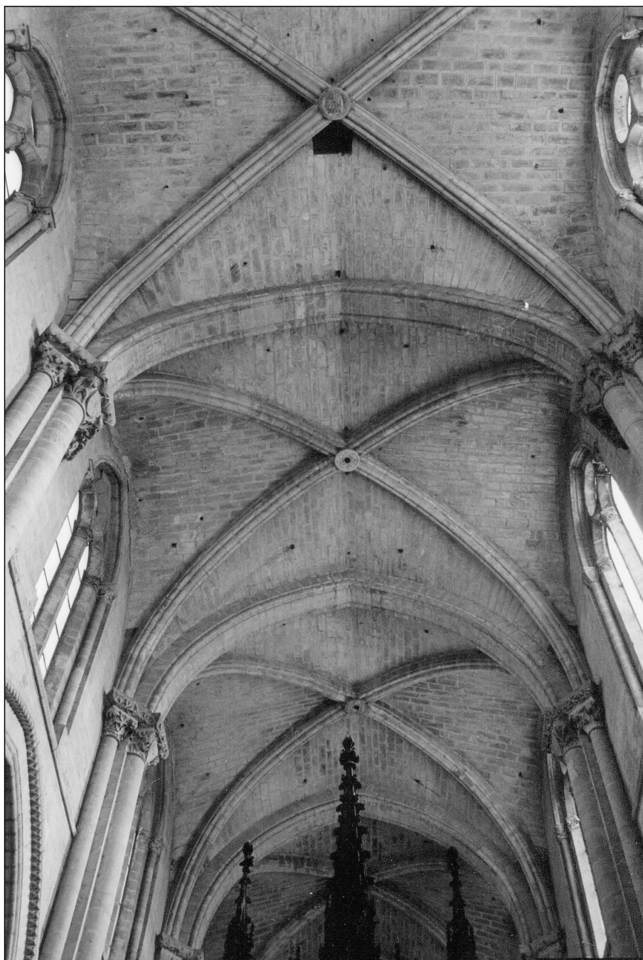
Lámina 11. Tudela. Catedral. Bóvedas de la nave mayor
