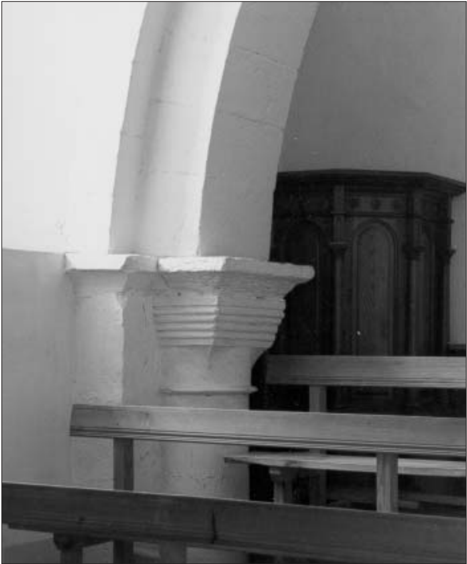
Lámina 12. Santa Eugenia de Mues. Capitel pilar del coro
