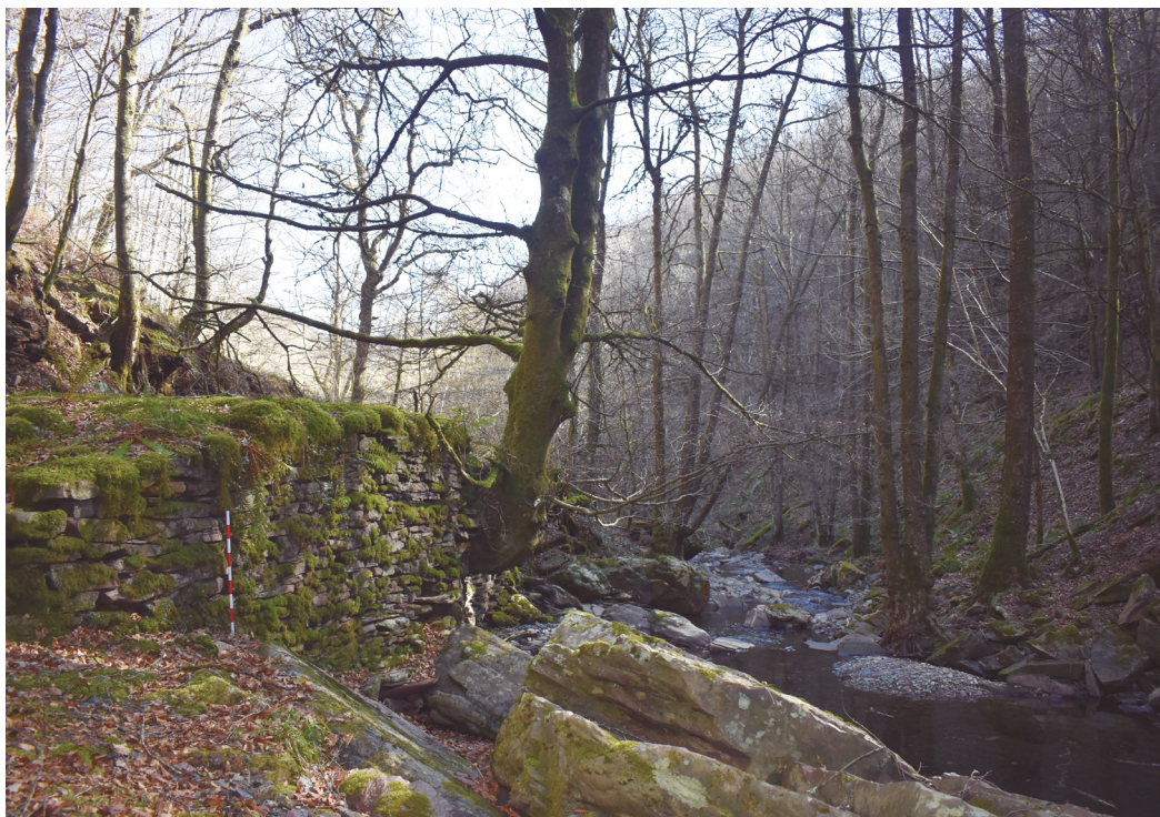
Figura 5. Lugar donde se localizaría la presa y parte de la primera estructura en Sarasain. Fotografía del autor.
