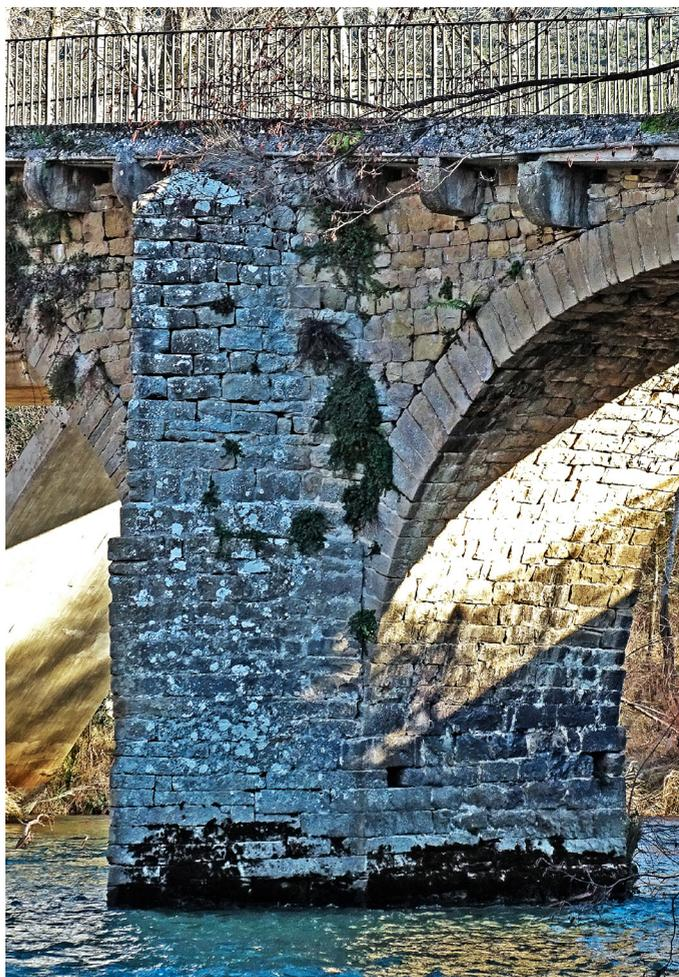
Figura 4. Pila occidental desde la margen derecha, que permite advertir el trabado de los sillares del tamar en la base y su yuxtaposición superior (enero 2023). Fotografía del autor.
