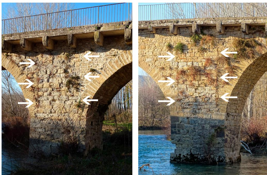
Figuras 5 y 6. Pilas central y oriental del puente, aguas abajo, que muestran la huella de sendos pilares embebidos (enero 2023). Fotografía del autor.
