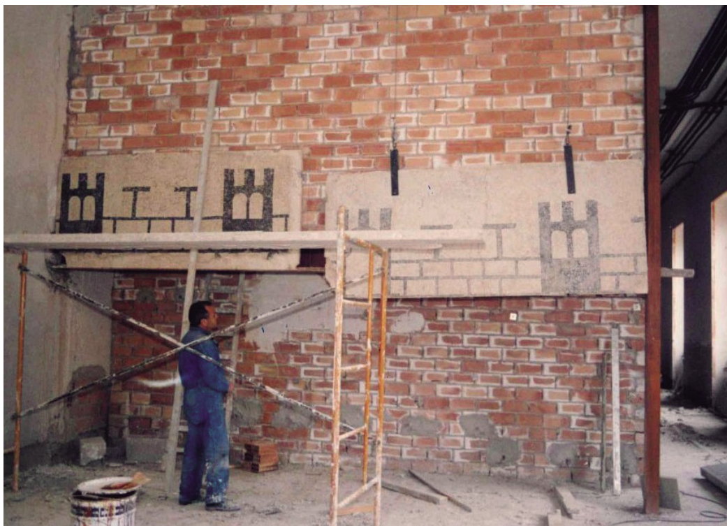
Figura 2. Colocación del mosaico durante las obras de reforma 1986-1990. Fotografía: Museo de Navarra.
