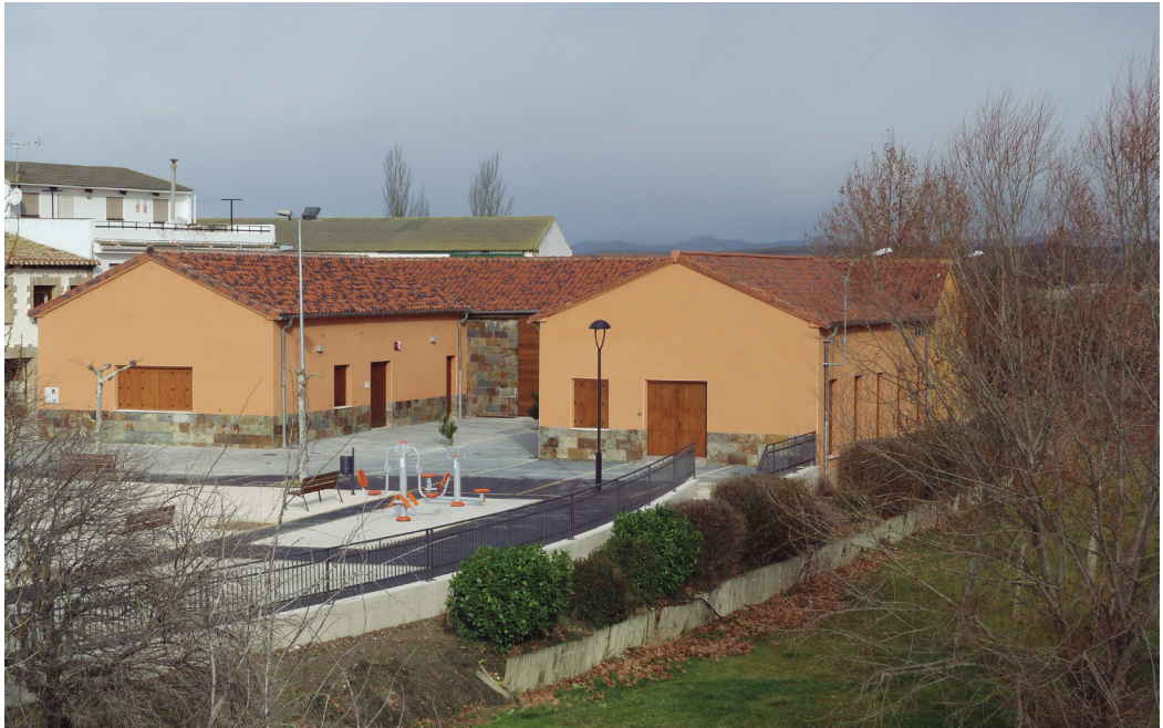
Figura 3. Edificio de la antigua conservera «Sagarcho» rehabilitado para acoger el Museo Arqueológico Las Eretas. Fotografía de Javier Armendáriz.
