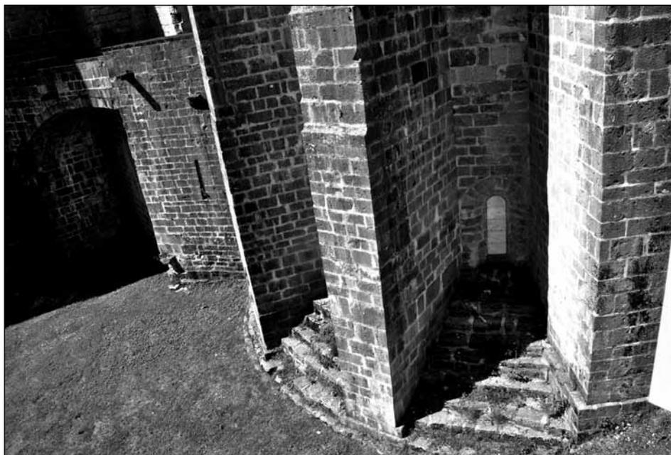
Figura 7. Roncesvalles. Gradas y cimentación del exterior de la cabecera.
