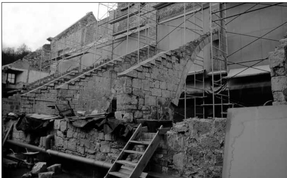
Figura 11. Roncesvalles. Arbotantes sobre la nave meridional durante las obras de sustitución de cubiertas.
