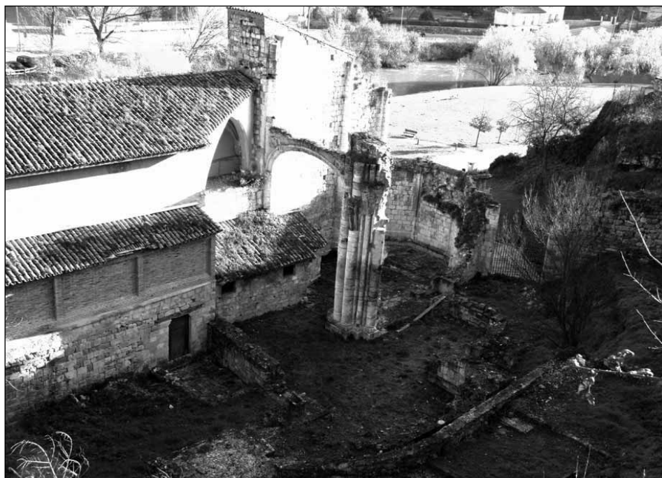
Estella. Exterior del Santo Sepulcro. Vista general de las cimentaciones no concluidas.
