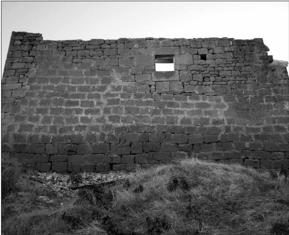
Lienzo de la muralla conservado en el lado norte. Reutilizado y modificado como pared de vivienda.
