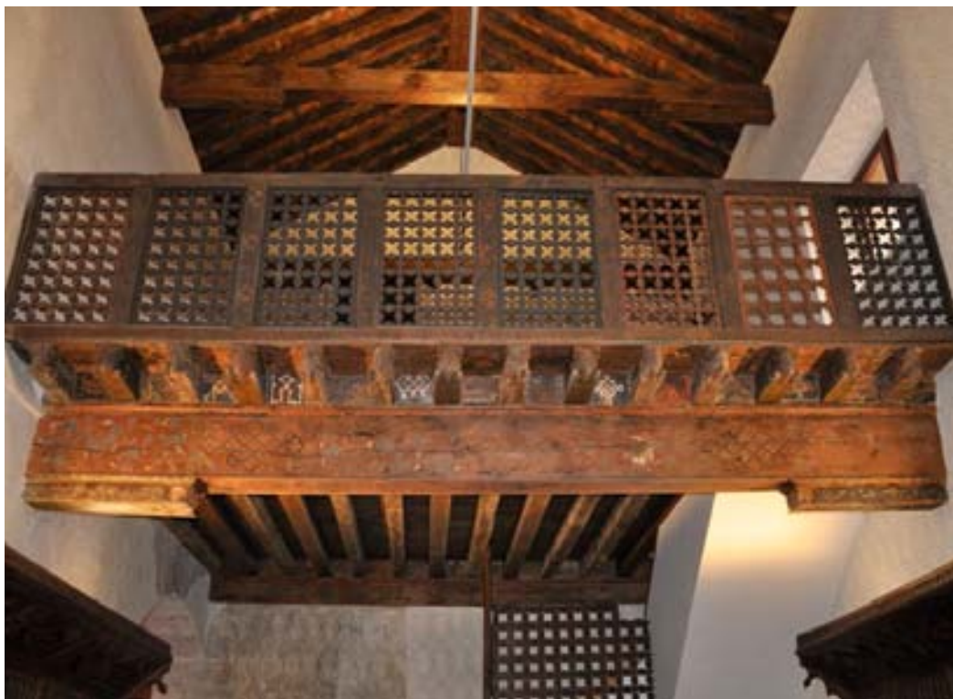
Figura 2. Vista del coro en alto y cubierta de madera de la capilla de San Dionís. Catedral de Tudela. Foto: M. J. Tarifa.
