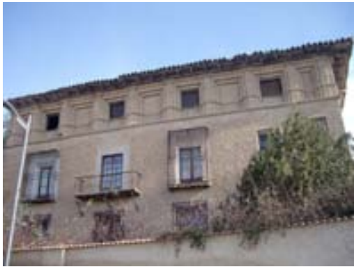
Figura 5. Fachada posterior de la casa de los García de Salcedo.
