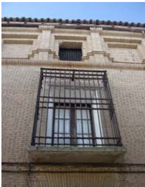
Figura 8. Detalle de una reja y de la galería del ático.
