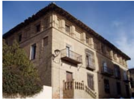
Figura 6. Fachada lateral de la casa de los García de Salcedo.
