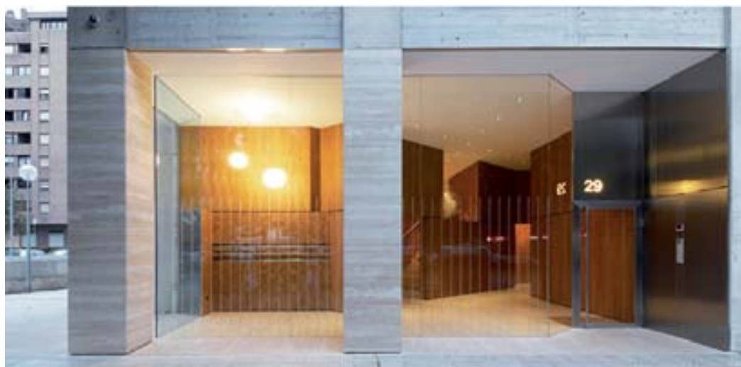
Figura 14. Reforma de portal del bloque de viviendas de la Avd. Pío XII, 29. Pamplona. Arquitectos: Iñaki Bergera e Iñigo Beguiristain. 2009.
