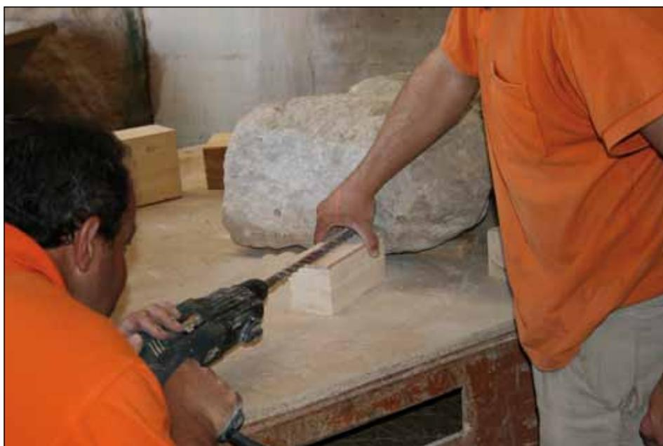
Proceso de perforación y colocación de las varillas roscadas.
