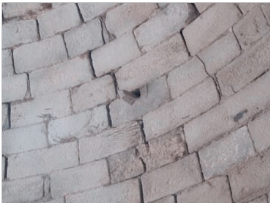
Figura 8. Caño vertedor fragmentado.
