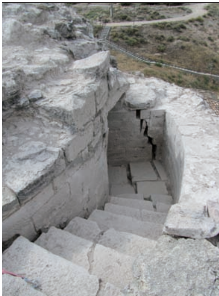
Figura 3. Escalera interna de comunicación entre plantas.
