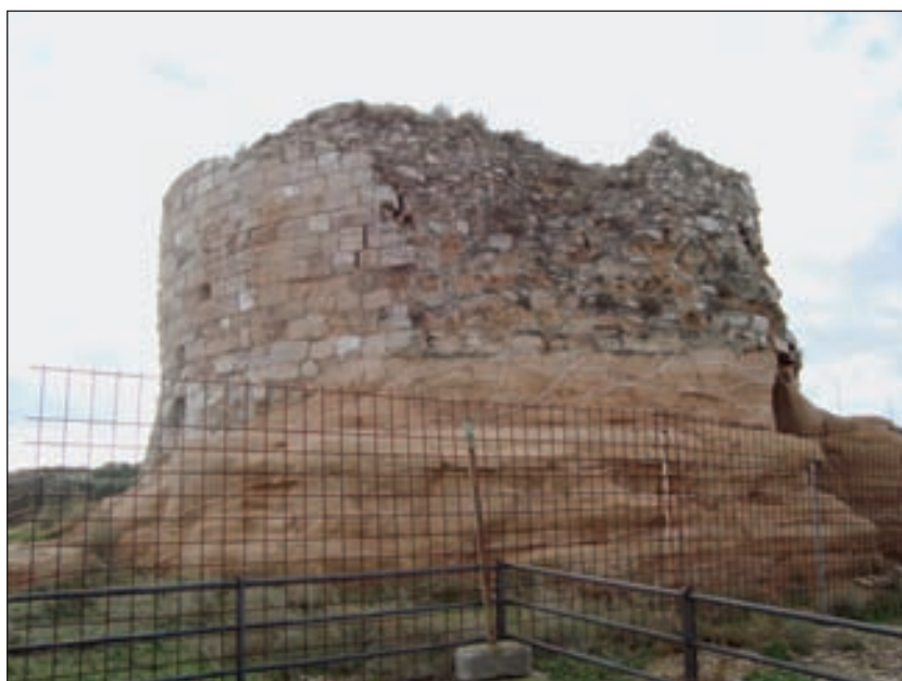
Figura 1. Cuerpo inferior del torreón mayor del castillo de Ablitas.
