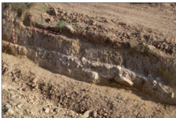
Figura 2. Sección transversal sur de la calzada en la zona denominada como área 1.
