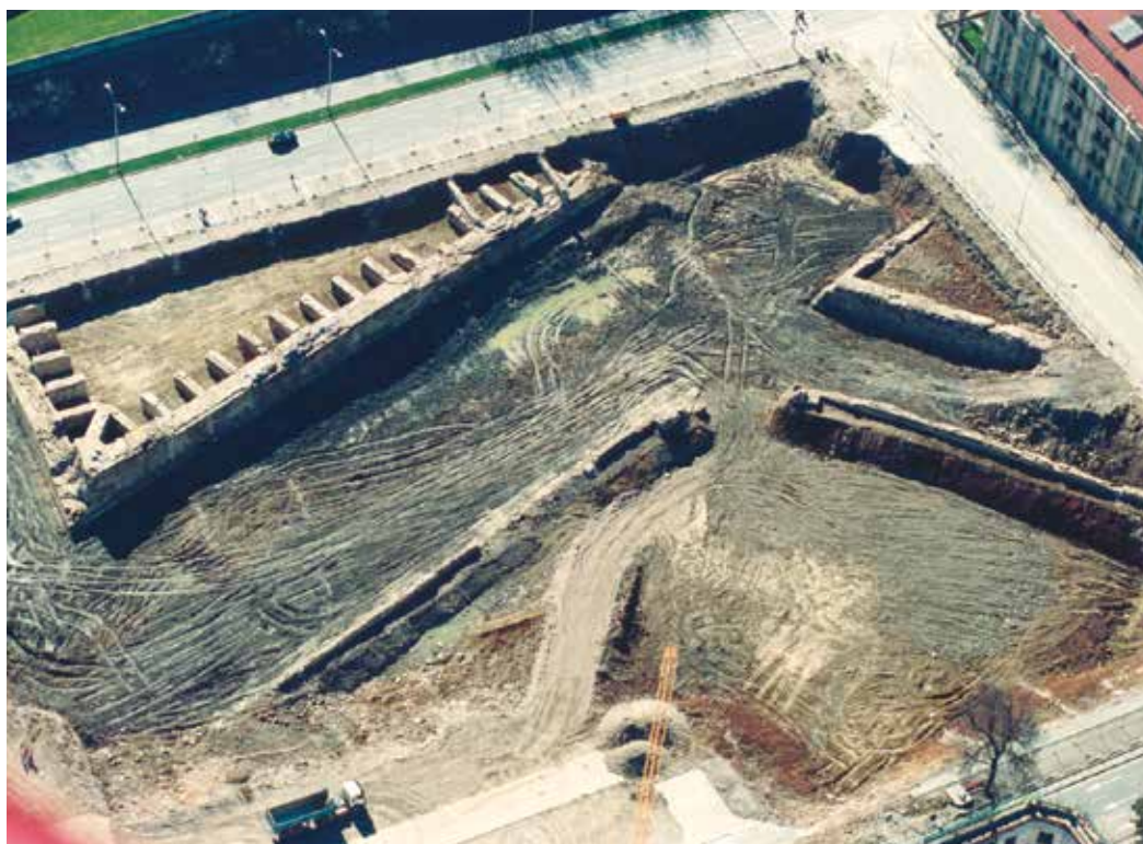
Figura 63. Vista general de la excavación del Palacio de Congresos.
