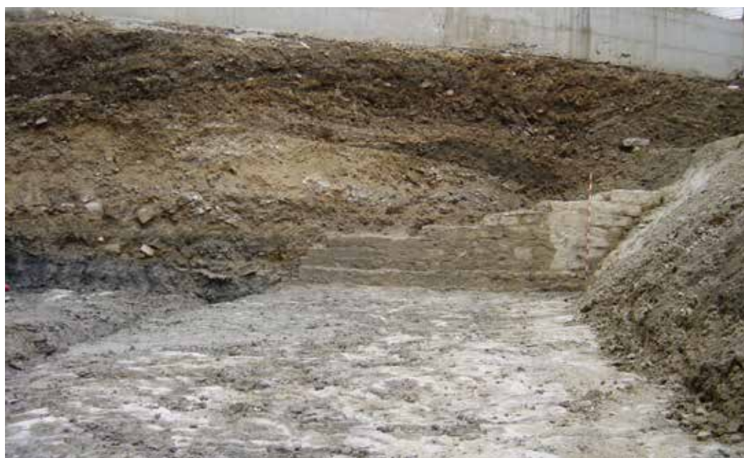
Figura 51. Vista general de las estructuras del castillo de Santiago.
