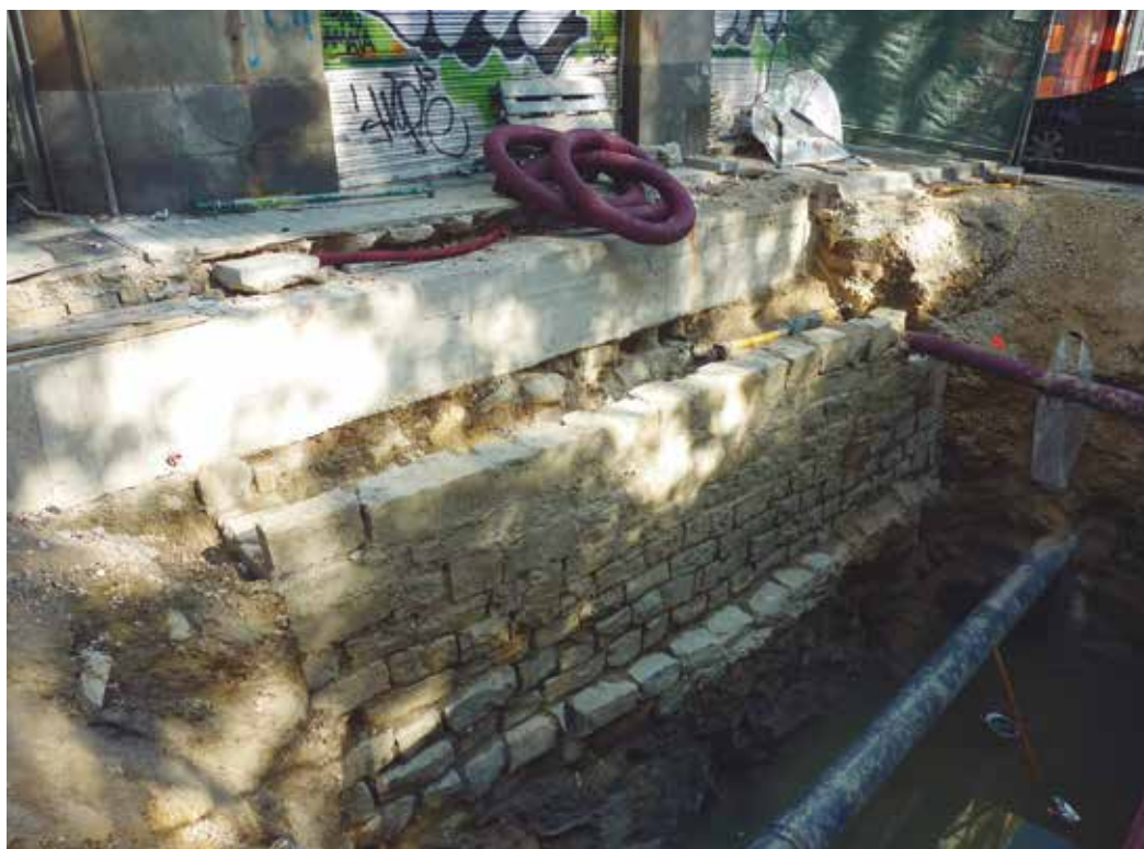
Figura 30. Torre en la calle Juan de Labrit.
