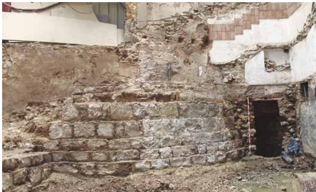
Figura 24. Detalle del torreón.
