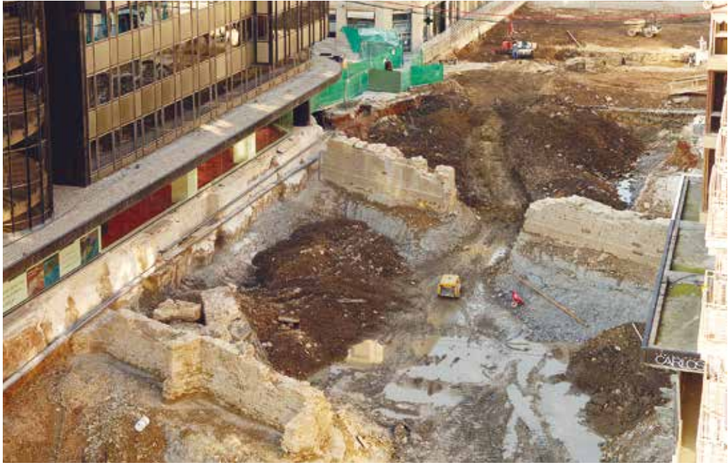
Figura 66. Vista general del baluarte de la Reina.
