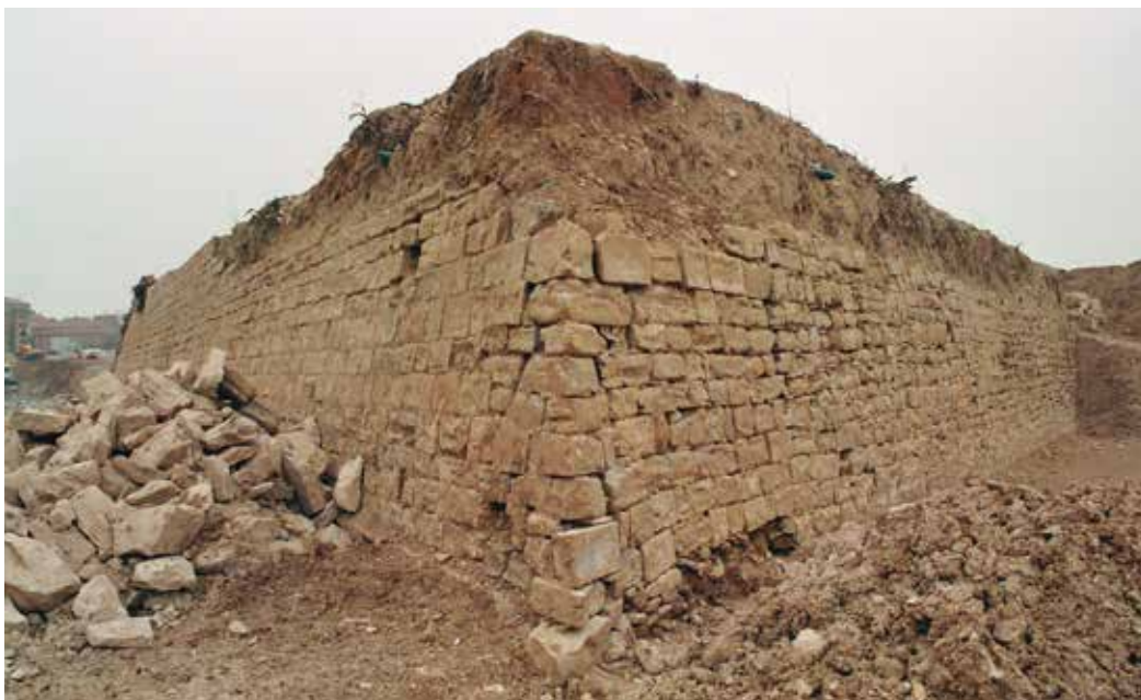
Figura 68. Detalle de las camisas del revellín de Santa Lucía.
