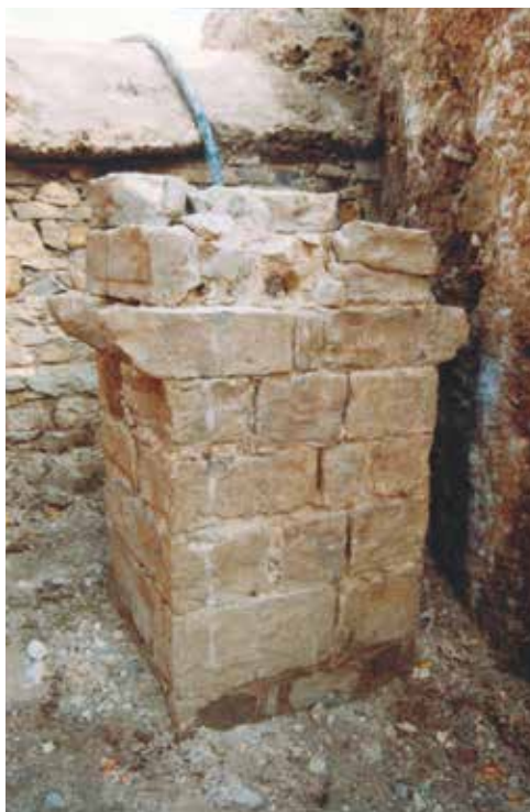
Figura 64. Detalle de un pilar puente acceso a la ciudadela.
