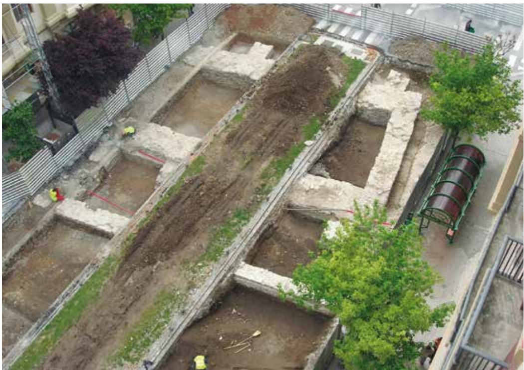
Figura 67. Cimentaciones del polvorín del baluarte.
