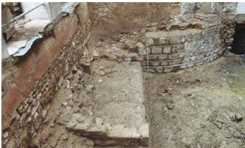
Figura 23. Escarpa y torre.
