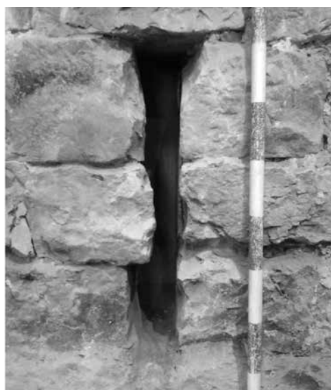
Figura 45. Detalle de la aspillera en el muro de la iglesia de San Nicolás.
