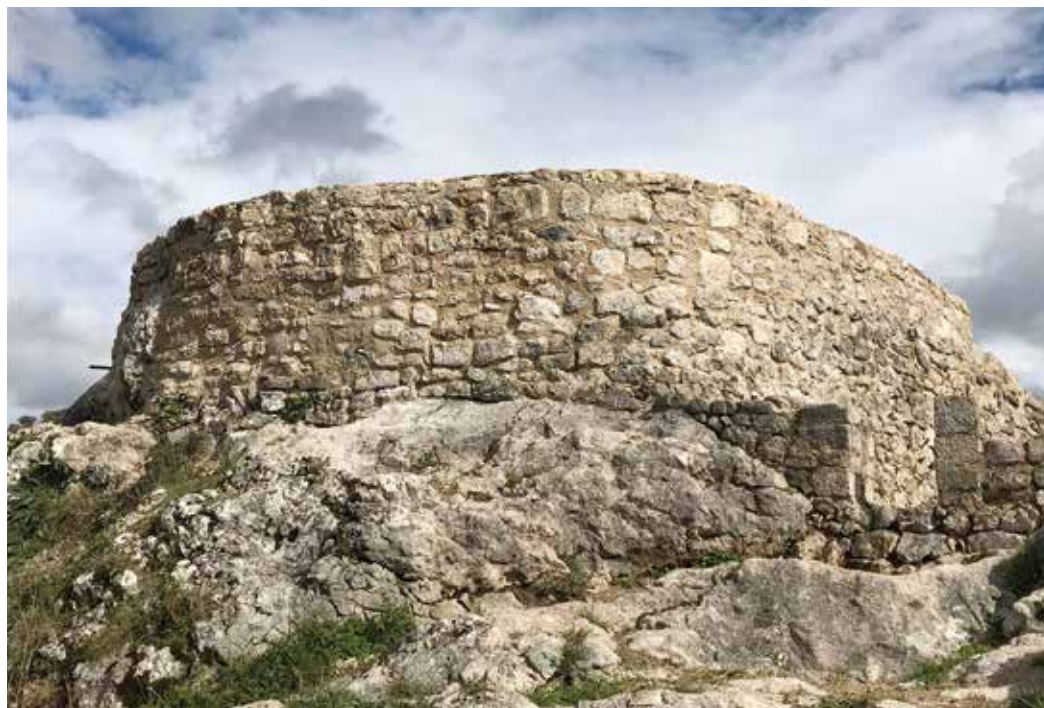
Figura 2. Vista de la torre del homenaje tras su consolidación en la actual campaña.
