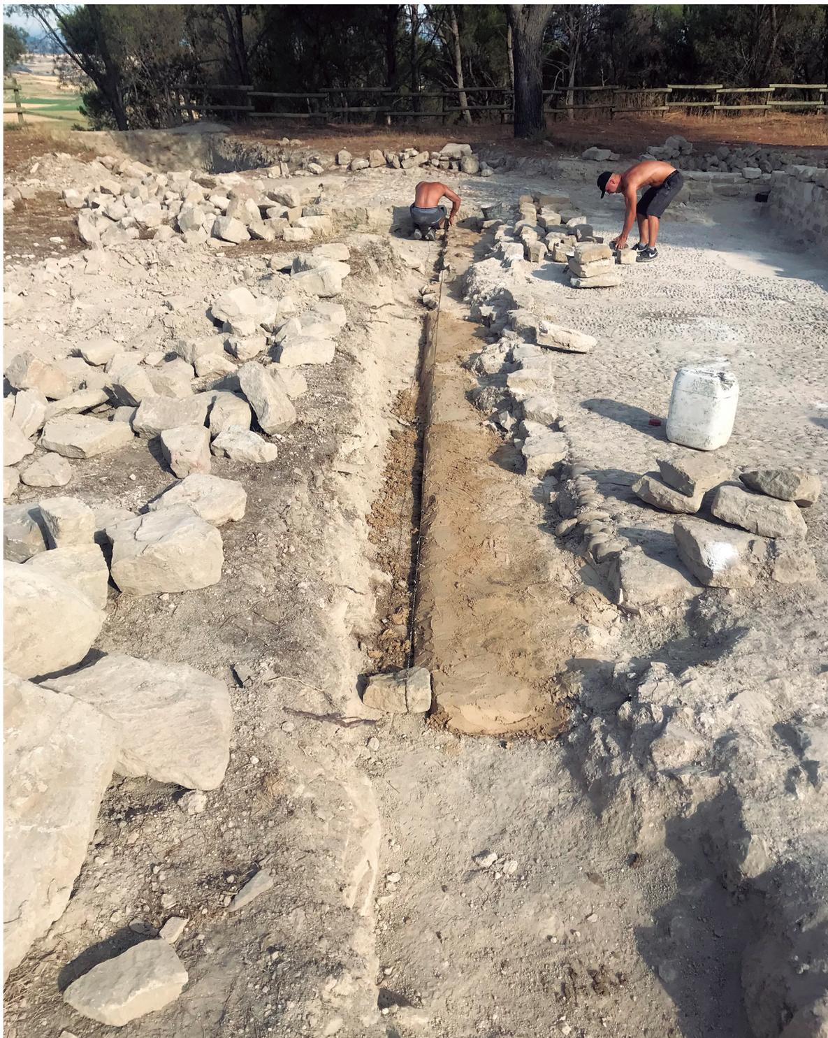
Figura 5. Construcción de basamento para la consolidación-reconstrucción del muro oeste, sin el cual el suelo de cuarcita se desmoronaría.
