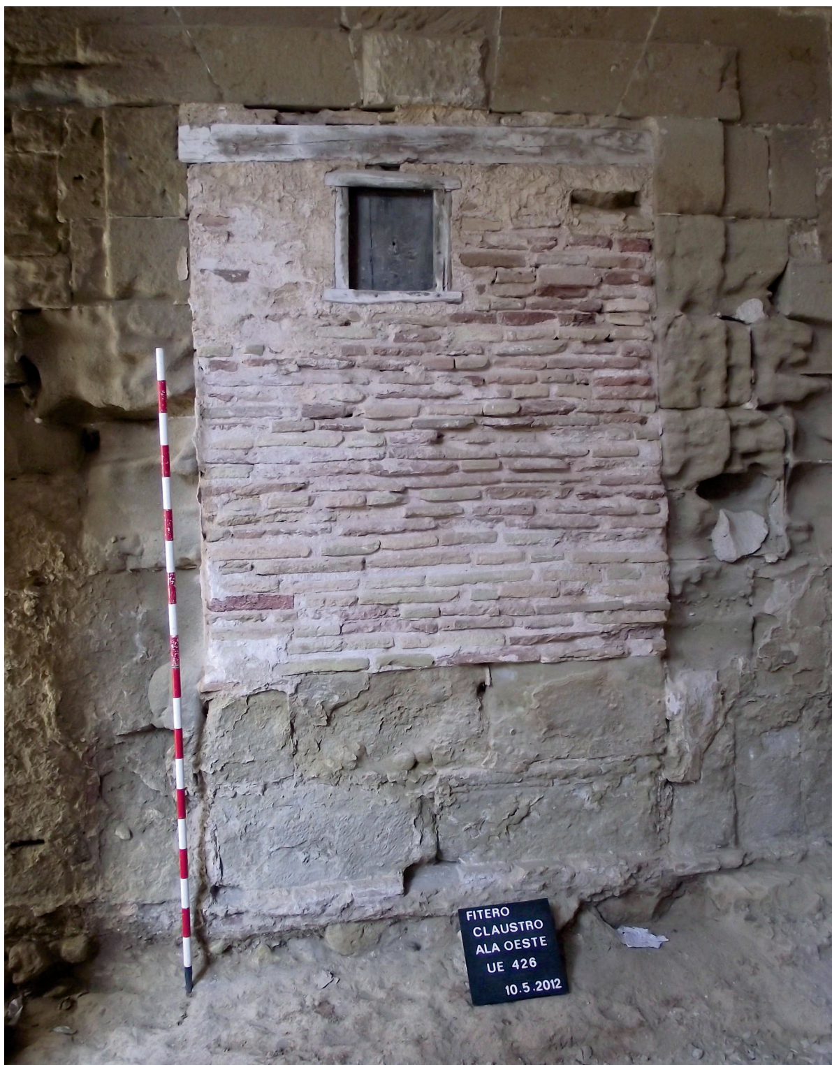
Figura 21. Puerta herreriana, hoy cegada, en la crujía oeste del claustro (Navark S.L.).
