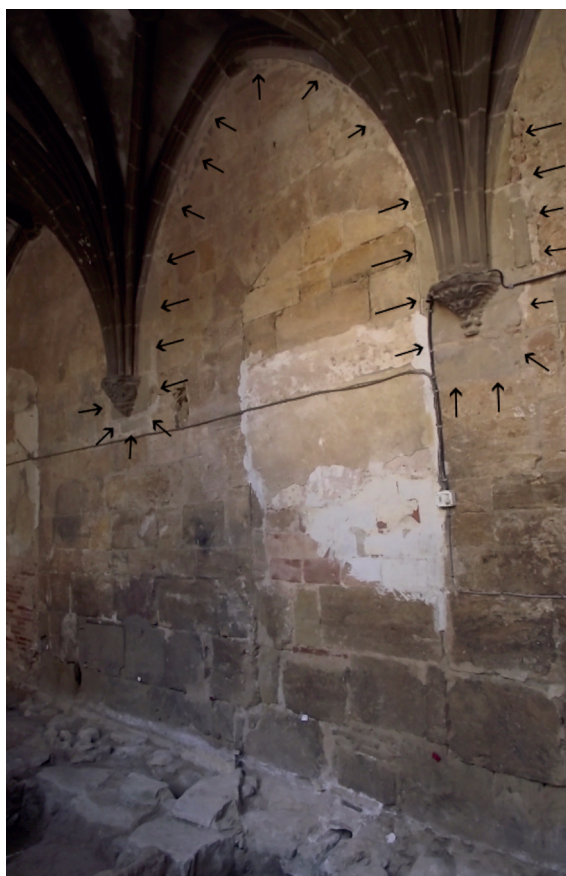
Figura 20. Corte efectuado (marcado con flechas) en el muro oriental del claustro (siglo XVI) (Navark S.L.).
