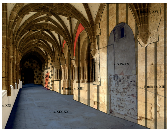
Figura 5. Fases constructivas de la crujía oriental del claustro (Navark S.L.).
