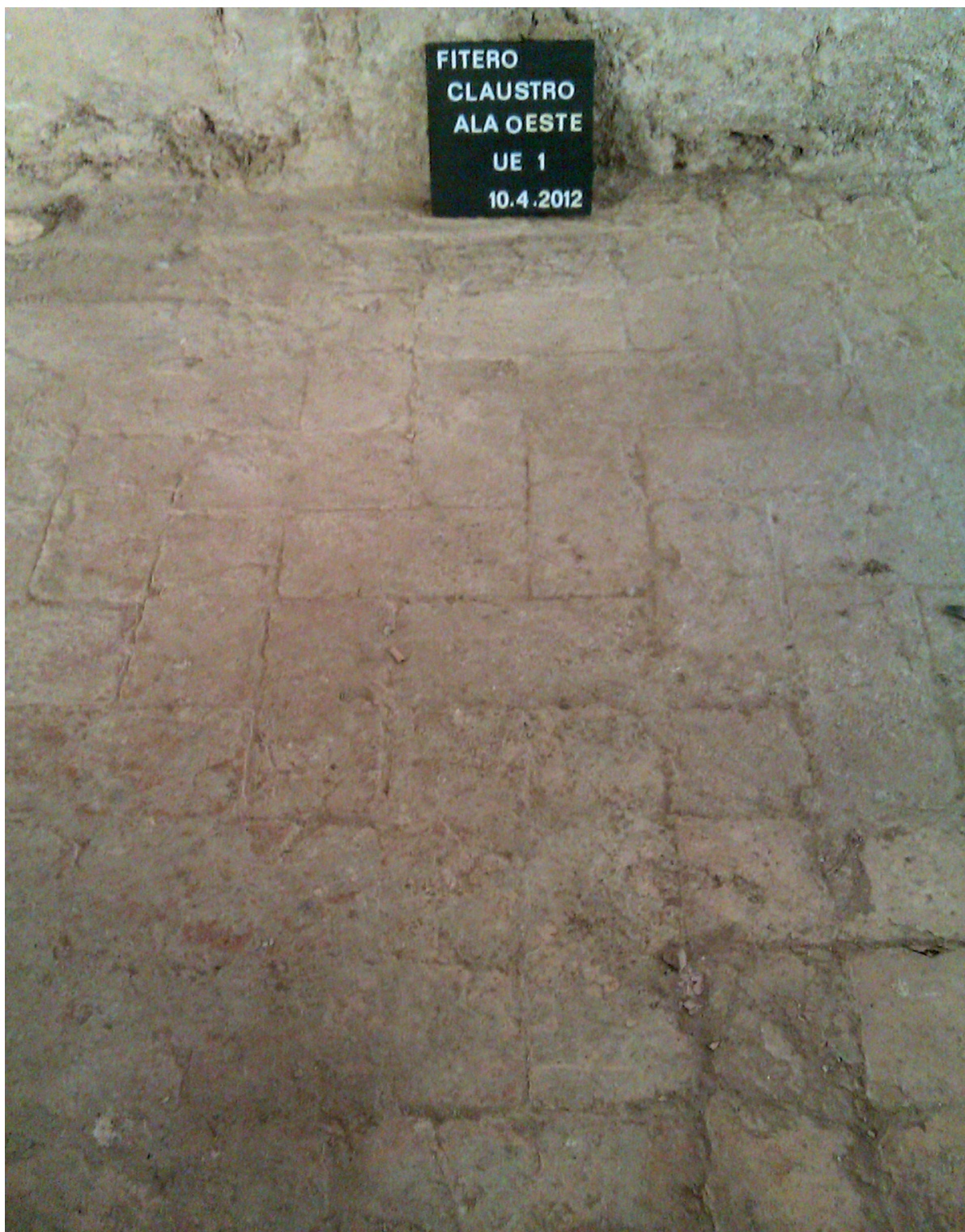
Figura 28. Suelo de enladrillado a la mezcla del claustro antes de la restauración (siglo XIX) (Navark S.L.).
