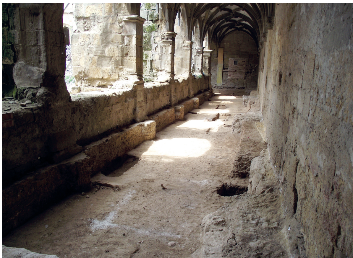
Figura 8. Cimentación del banco del claustro con los engrosamientos de refuerzo para los pilares de la arquería (crujía norte) (Navark S.L.).
