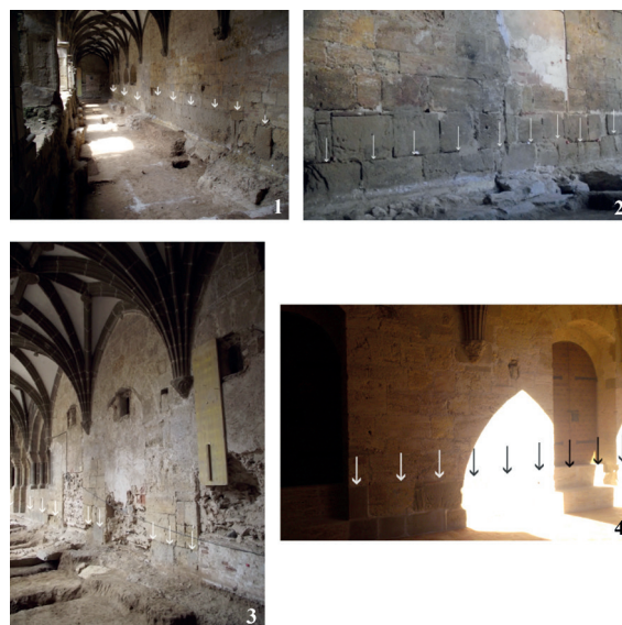
Figura 17. Hiladas de piedra de mala calidad visibles tras el rebaje del suelo del claustro (siglo XIV); las flechas marcan el nivel original del pavimento claustral (1, crujía norte, 2 y 3, panda este y 4, el mismo muro oriental tras la restauración) (Navark S.L.).
