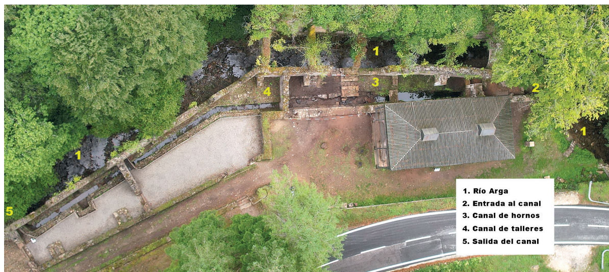
Figura 1. Vista área del canal con información sobre su recorrido.
