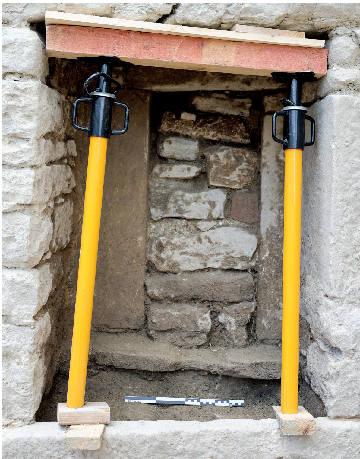
Figura 3. Detalle de la pileta de captación de agua.
